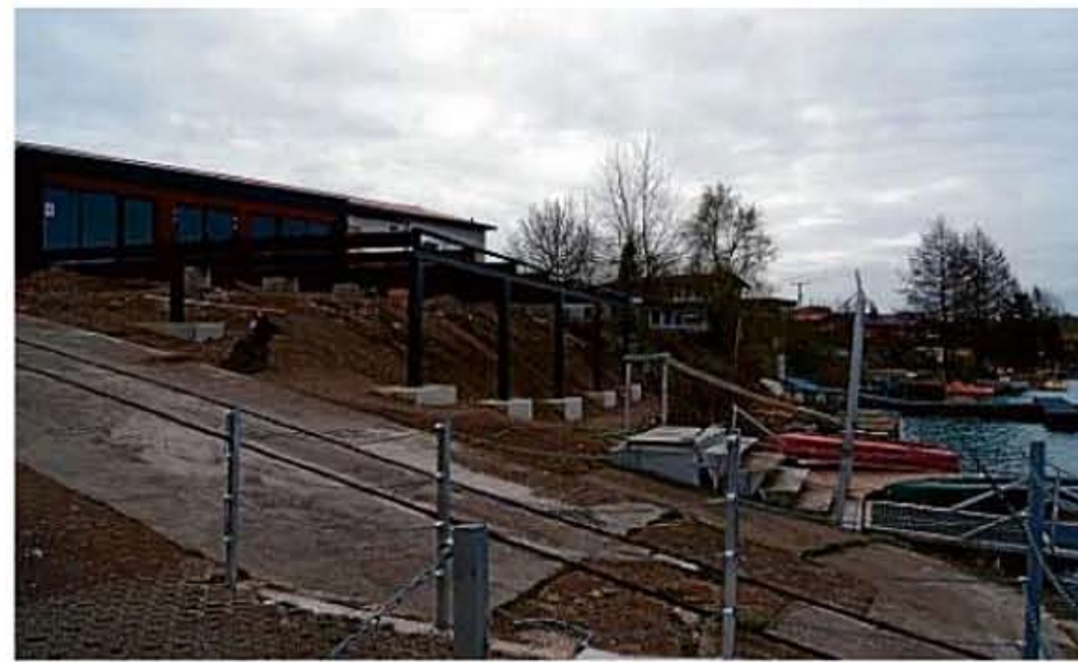
Ein Blick auf den Hang gibt einen Eindruck von den aufwendigen Sicherungsarbeiten.
